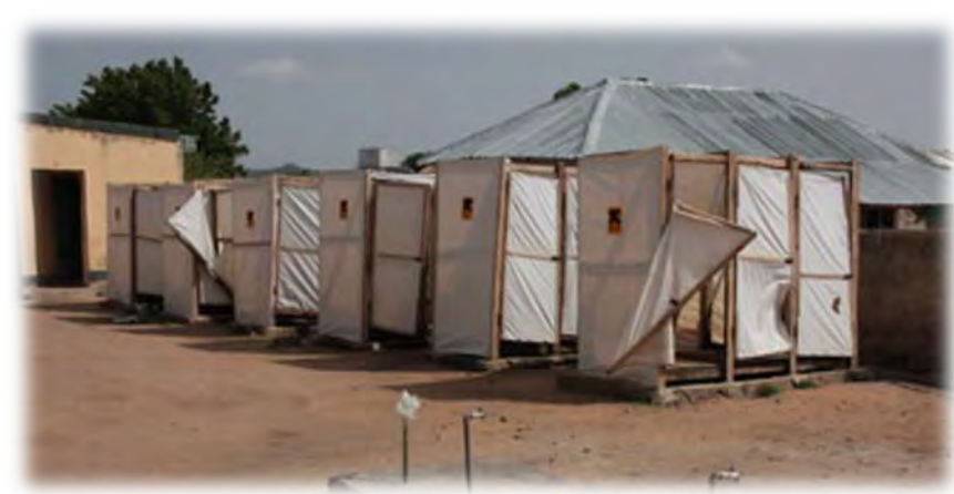
Pollution des sols et eaux de surface
